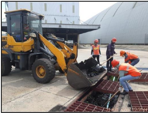
ภาพที่ 2.37 การขุดลอกระบบระบายน้ำภายในพื้นที่โครงการ
