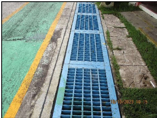
ภาพที่ 2.36 รางระบายน้ำฝนรอบโครงการ
