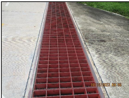
ภาพที่ 2.18 รางระบายน้ำภายในพื้นที่โครงการ
