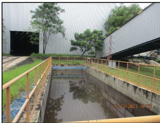
ภาพที่ 2.35 บ่อดักคราบน้ำมันและไขมัน (Oil Separator)
