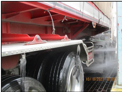
ภาพที่ 2.9 บ่อล้างล้อรถบรรทุกก่อนออกจากพื้นที่โครงการ
