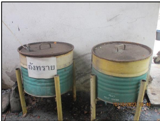
ภาพที่ 2.20 ถังทรายดูดซับน้ำมันบริเวณท่าเทียบเรือของโครงการ
